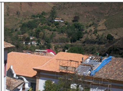
Figura 13 – Vista do telhado da igreja, em obras.
