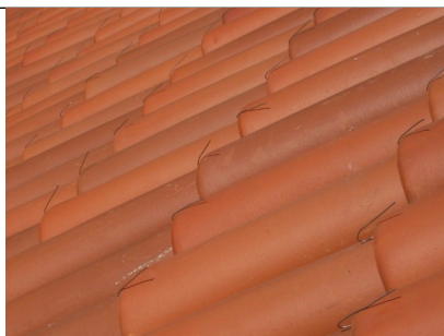
Figura 12 – Telhas novas, com arame para amarração.
