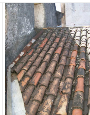
Figura 16 – Telhas mais recentes.
