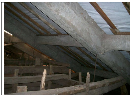
Figura 11 – Tesouras em concreto armado na cobertura.
