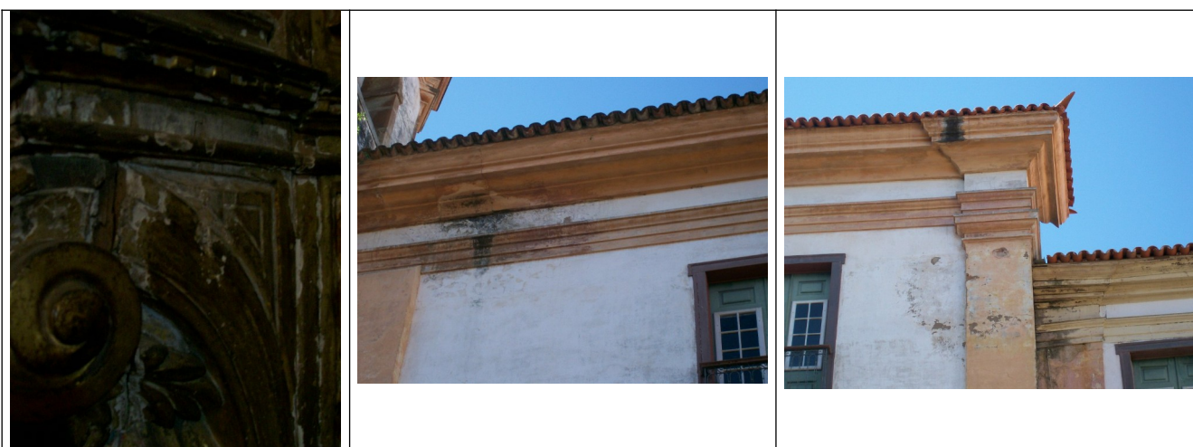
Figura 08 – Perda de douramento no retábulo.
