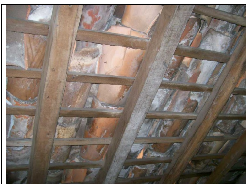
Figura 14 – Vista das telhas sob a cobertura.
