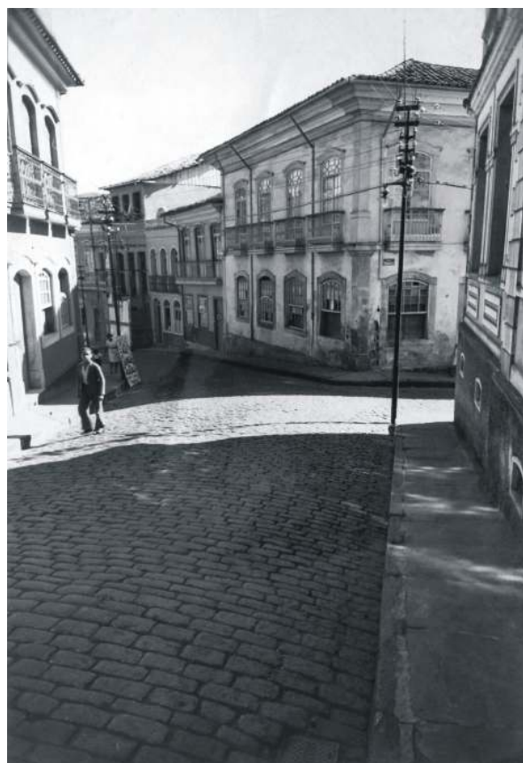
Casas à Rua São José. Fotografia: Eric Hess, 1939.
