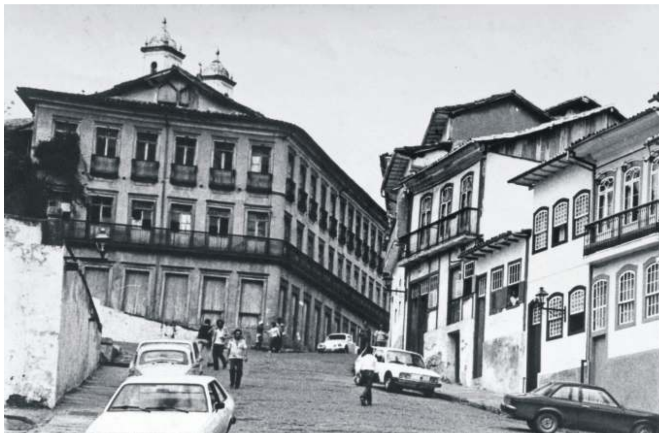
Casas do Largo e da Ladeira do Rosário. Fotografia: Pedro Lobo, 1980.
