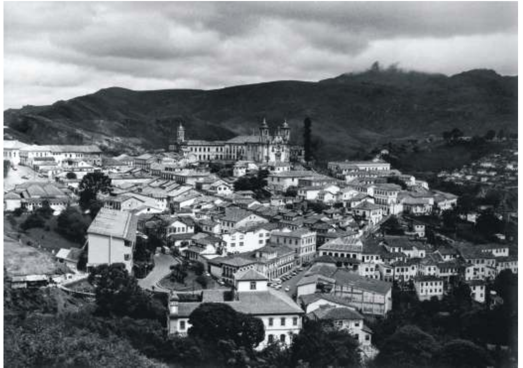
Conjunto arquitetônico e urbanístico. Fotografia: Pedro Lobo, 1980.
