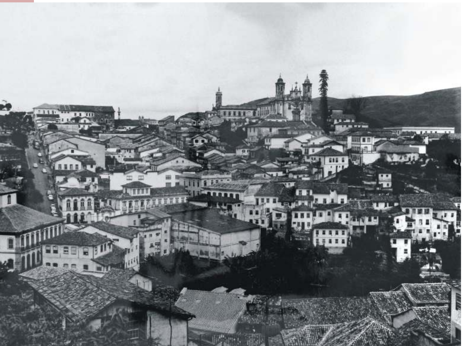
Conjunto arquitetônico e urbanístico. Fotografia: Pedro Lobo, 1980.
