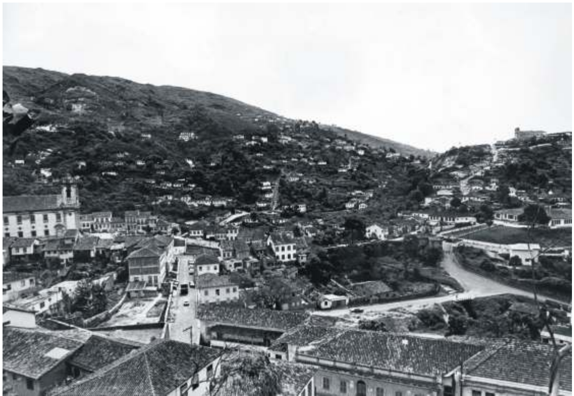
Conjunto arquitetônico e urbanístico. Fotografia: Renato Morgado, 1980.
