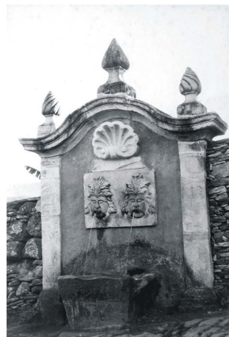
Chafariz Barão do Rio Branco, (1761). Fotografia: Eric Hess, s/d.
