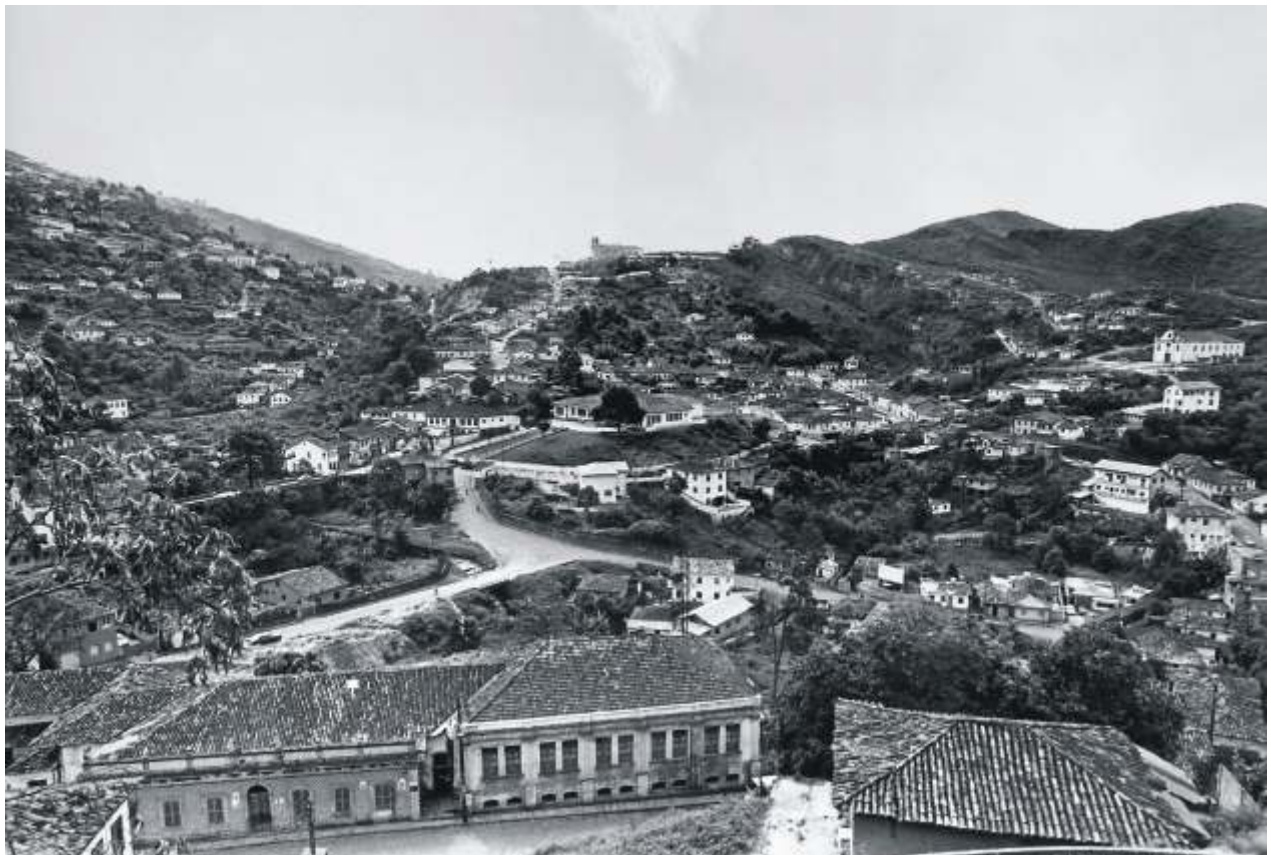
Conjunto arquitetônico e urbanístico. Fotografia: Renato Morgado, 1980.
