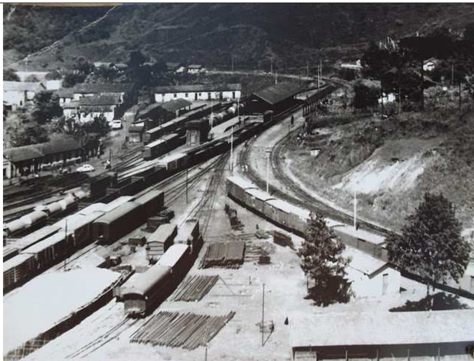
Figura 02 - Conjunto Ferroviário de Miguel Burnier. Conjunto da Estrada de Ferro Central do Brasil, no cruzamento entre a "Linha do Centro" e o "Ramal de Ponte Nova". Década de 1950. Fonte: Dossiê de Tombamento
