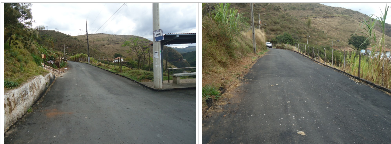
Figuras 18 e 19 – Imagens da rua Engenheiro Corrêa, de acesso ao Museu Casa dos Inconfidentes. Fotos da vistoria.
