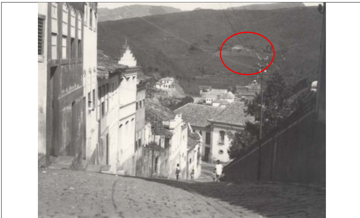
Figura 11 – Imagem da edificação (em destaque) a partir da rua Randolpho Bretas. Verifica-se a existência de trilha de acesso pelos fundos do casarão. Fonte http://www.ouopreto.mg.gov.br/luizfontana
