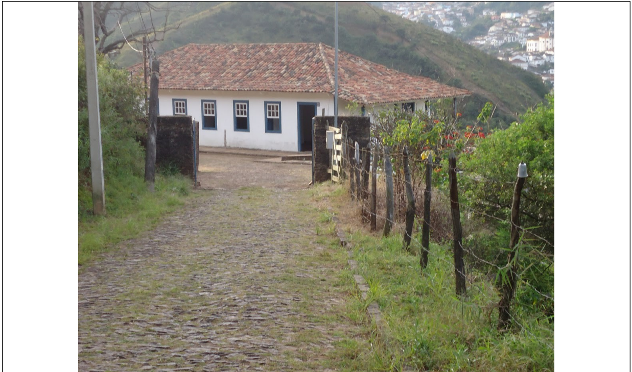
Figura 13 – Imagem do local antes da intervenção realizada.
