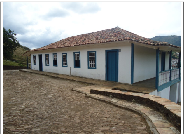
Figura 23 – Calçamento em pedras na área de entorno da edificação.
