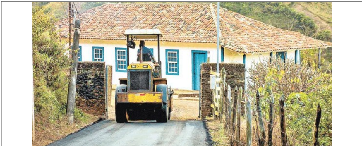
Figura 14 – Imagem da intervenção em execução. Fonte: Jornal Estado de Minas.
