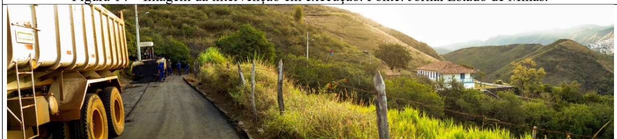
Figura 15 – Imagem da intervenção em execução.
