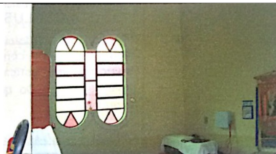
Figura 3 – Instalar redoma de vidro para exposição das peças sacras nesta sala. Fonte: COPLI-MGPMG.
