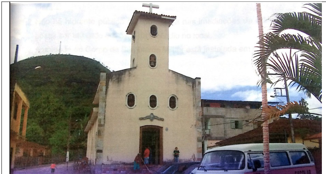
Figura 1 – Fachada frontal da Capela. Fonte: COPLI-MGPMG.
