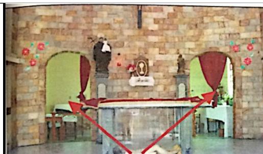
Figura 2 – Instalar portas reforçadas nestes vãos. Fonte: COPLI-MGPMG.
