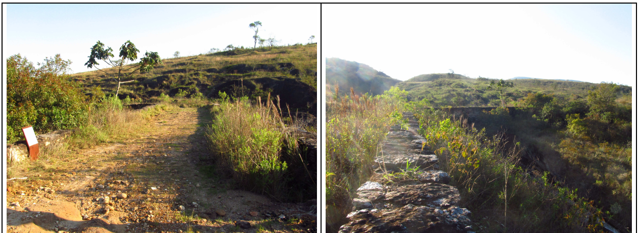
Figuras 35 e 36 – Danos na pavimentação e presença de vegetação nas estruturas.
