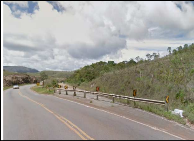
Figura 09 - Desvio e impedimento do tráfego sob o conjunto foi feito com guard-rail que não se integra à paisagem existente
