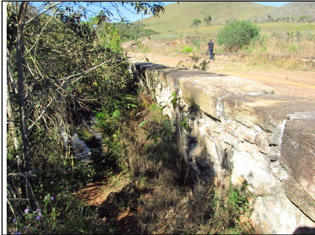
Figura 15 - O acesso ao trecho inferior das pontes é difícil, feito através de trilhas abertas pelos turistas, sem planejamento.
