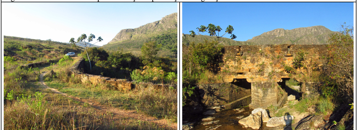
Figura 37 – Vista geral da estrutura.
