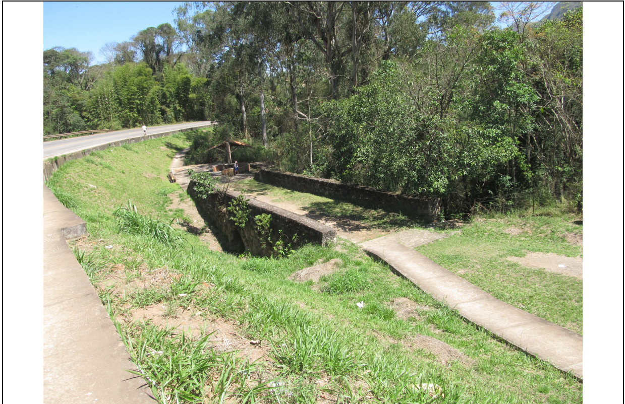
Figura 41 – Ponte próxima à Fazenda Pé do Morro.
