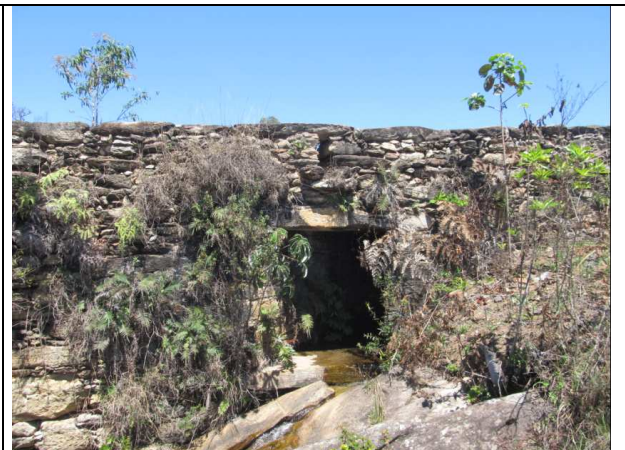
Figura 34 – Trecho inferior da Galeria de Drenagem – Bueiro de Itatiaia.
