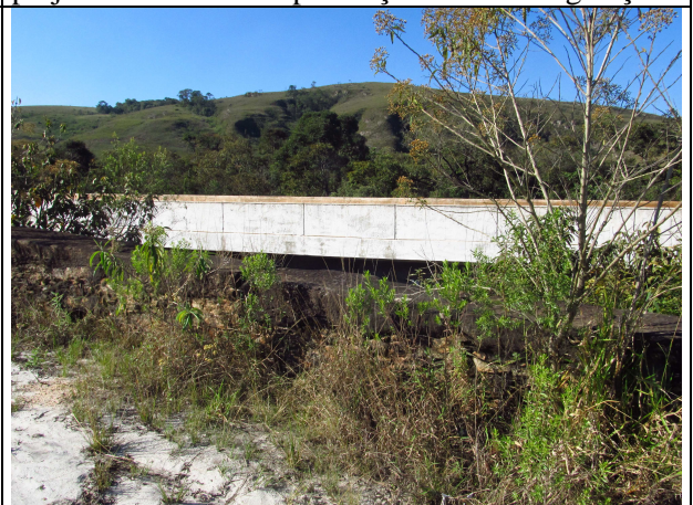
Figura 20 – Vista da ponte nova na lateral da antiga. Verifica-se a presença de vegetação junto da estrutura de pedra.
