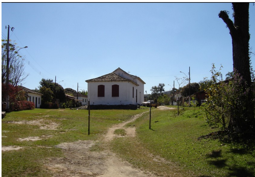
Figura 7 - Parte posterior da Capela de Santana sem a presença da antena. Foto de 2004. Fonte: http://memoriaarquitectura.com.br/projetos/tombamento-da-capela-de-santana-chapada-ouro-preto-mg/ . Acesso 27-09-2018.
