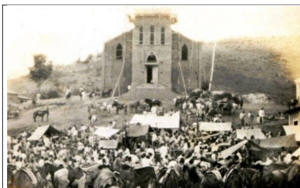
Figura 03 – Construção da Igreja Matriz de Padre Paraíso.
