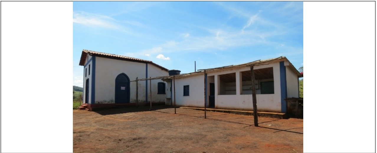
Figuras 05 e 06 – Visadas da capela de Santo Antônio, edificada na comunidade de Guardas.
