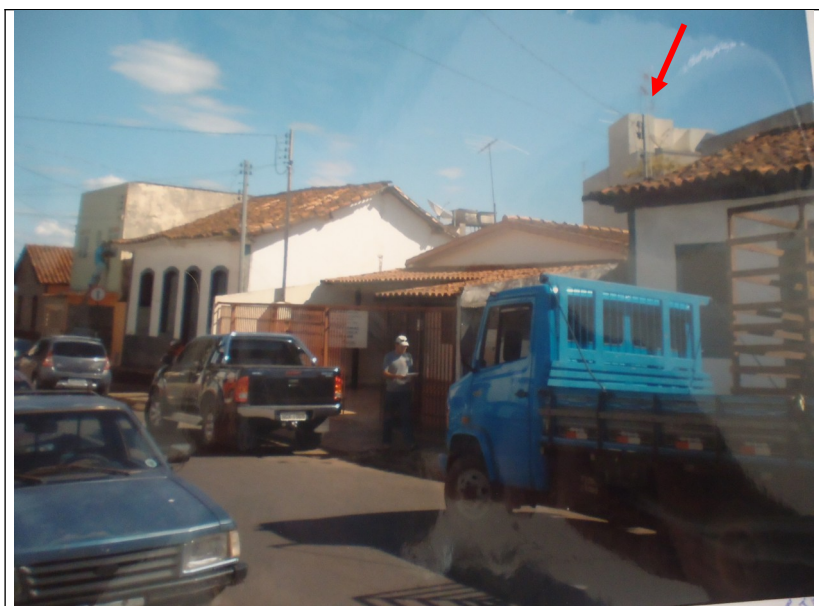
Figura 09 – Imagem da edificação a partir da rua Rubens Bitencourt.
