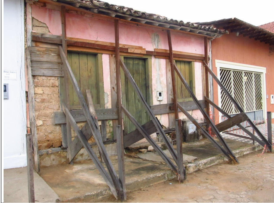
Figura 01 - Escoramento de alvenarias da fachada e da estrutura do telhado
