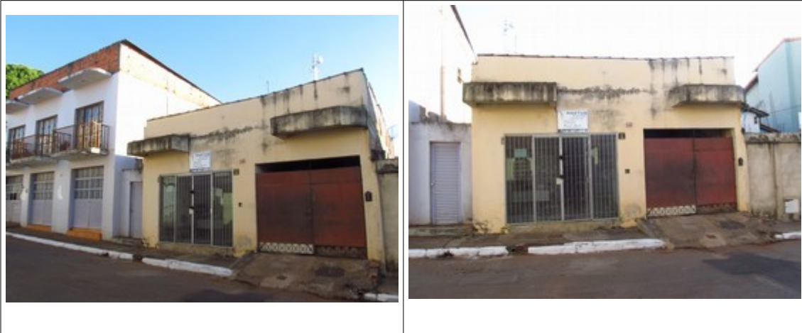
Figuras 5 e 6- Imóvel da Rua Benjamim Carneiro, nº 146. Fotos da vistoria.
