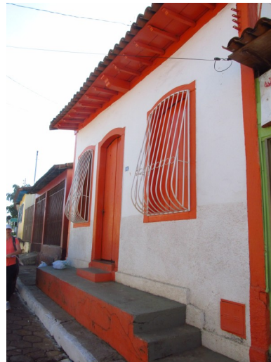
Figura 03 – Imagem da edificação em junho de 2017.
