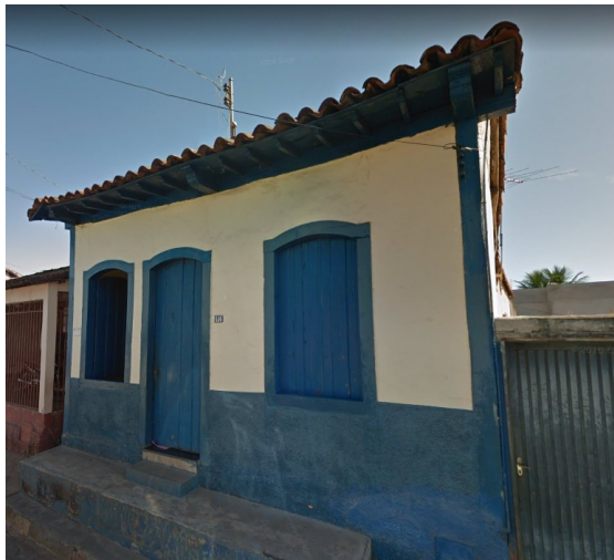
Figura 02 – Imagem da edificação em agosto de 2011.
