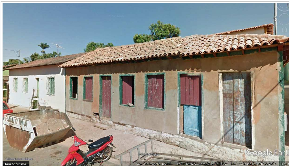
Figura 10- Imóvel da Rua Dr. Seabra, nº 183, em Paracatu. Fonte: GOOGLEEARTH, 2017. Data da imagem: 08/2011.
