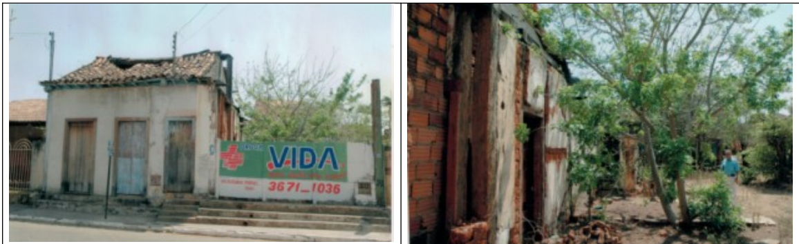
Figuras 3 e 4- Imóvel da Rua Dr. Seabra, nº 249 e lote do imóvel nº 251. Fotos constantes dos autos.
