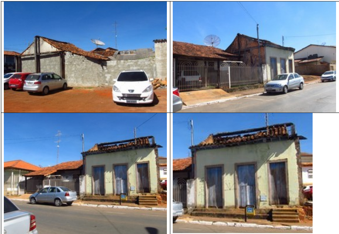
Figuras 5, 6, 7, 8, 9 e 10- Imóveis da Rua Dr. Seabra, nº 249/251. Fotos da vistoria realizada em junho de 2017.
