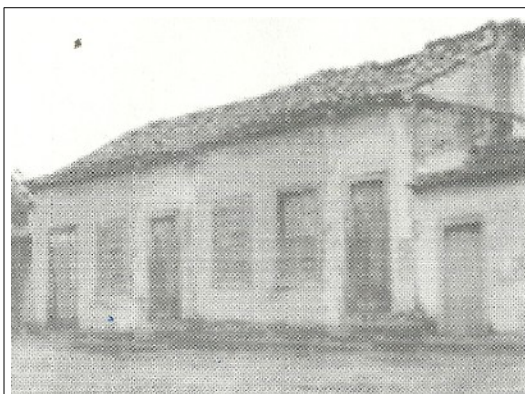
Figura 11 - Imagem antiga da edificação,
