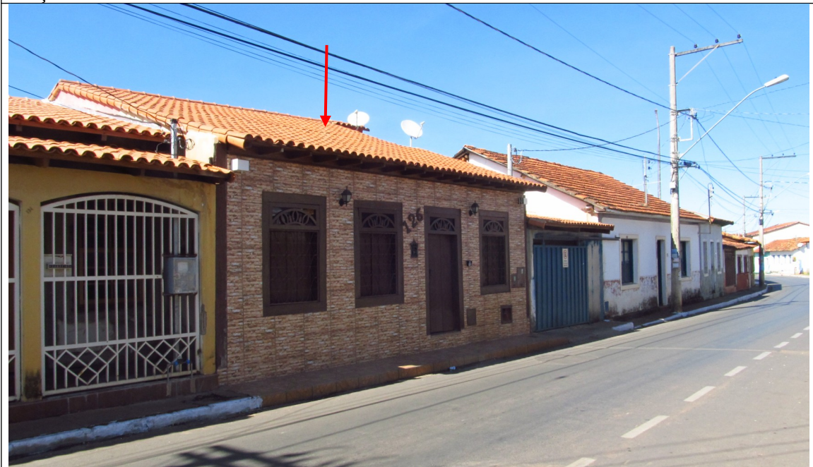
Figura 3 - Imóvel da Rua Dr. Seabra, nº 126 em Paracatu. Fotografia vistoria realizada em junho 2017.
