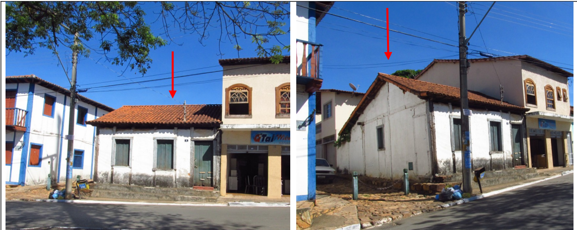
Figuras 1 e 2- Imóvel da Rua Dr. Seabra, nº 09 em Paracatu.
