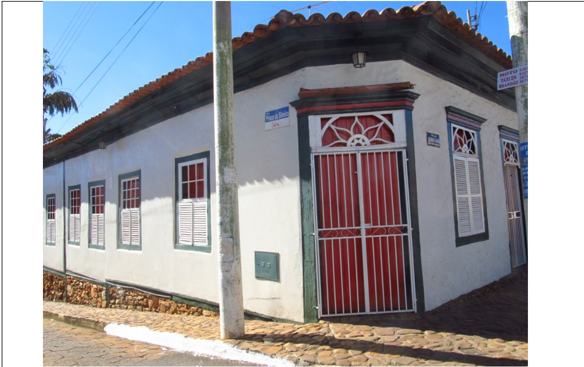
Figura 4- Porta inserida na esquina, seguindo a largura do vão, gradil defronte à porta e toldo retrátil sobre o vão. Foto da vistoria realizada por este setor técnico.
