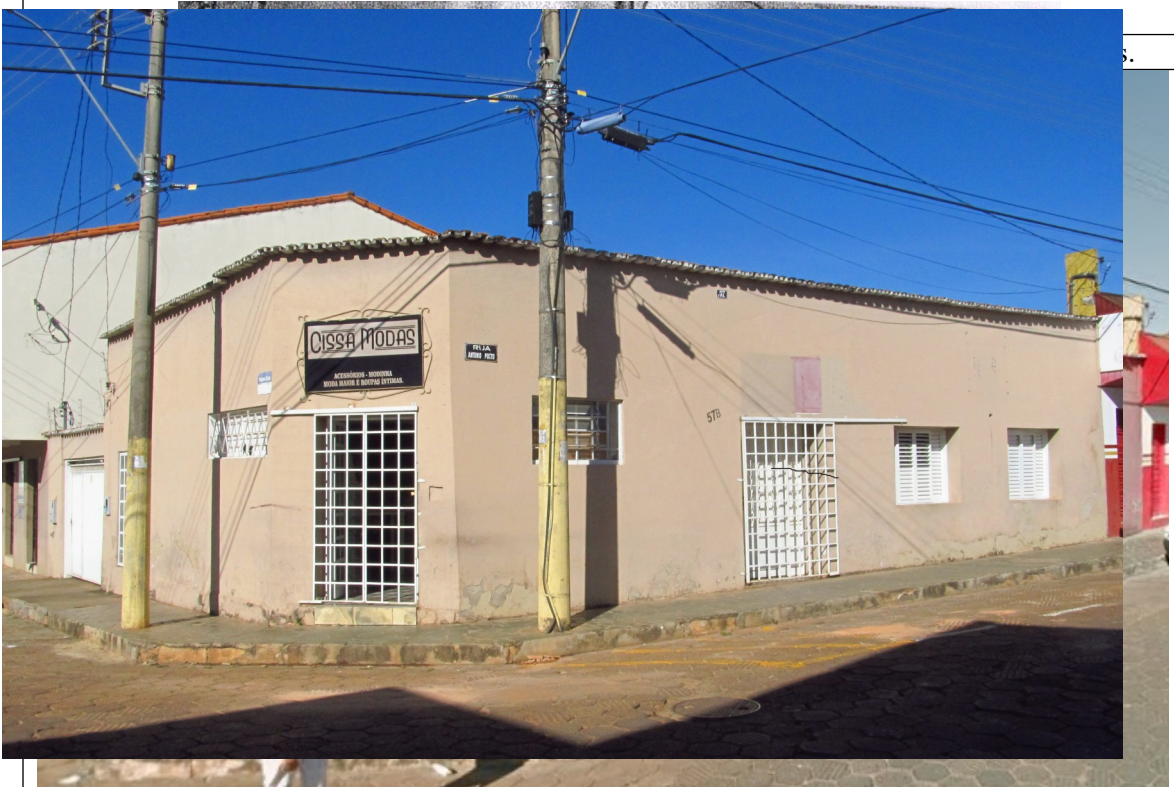
Figura 02 – Imagem do imóvel em 2011. Fonte: Google Street View.
