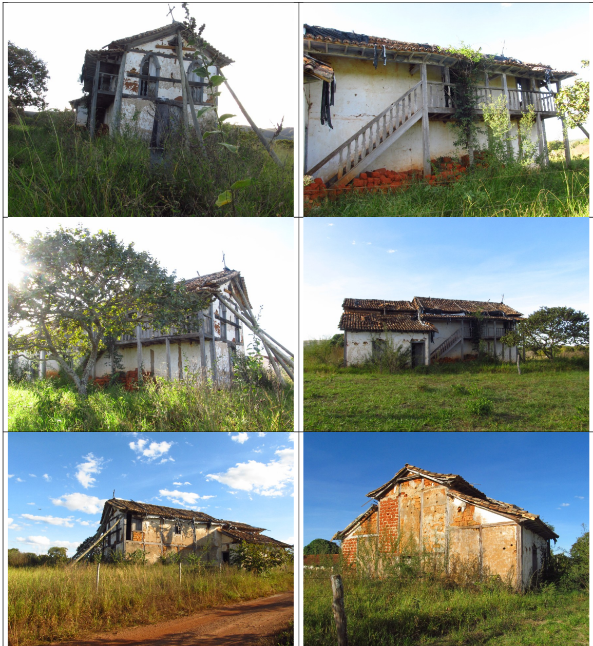
Figuras 8 a 15- Imagens externas da Capela de São Sebastião do Pouso Alegre. Fotos da vistoria.
