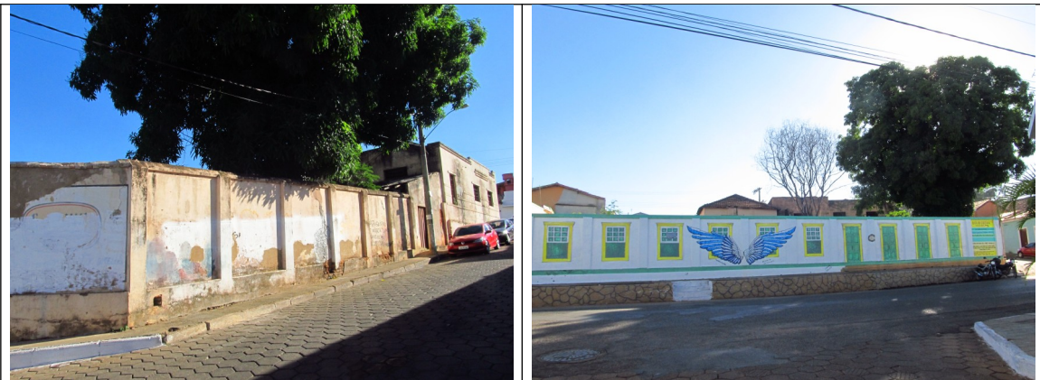
Figuras 1, 2, 3 e 4- Imóvel sede do Automóvel Clube em Paracatu. Nas duas últimas imagens é possível constatar a dimensão do terreno no qual a edificação está implantada.
