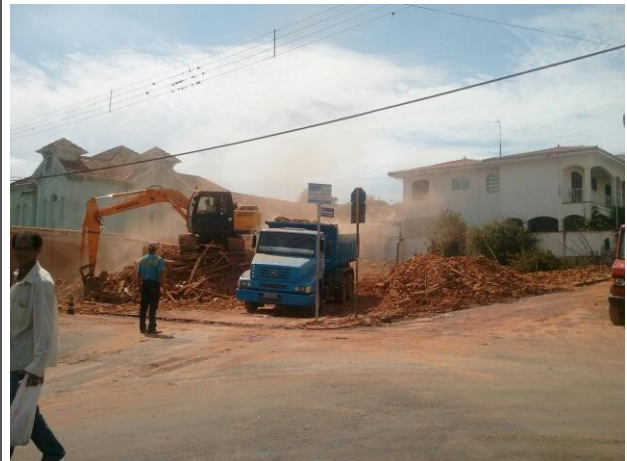
Figura 13 – Acima imagem da retirada do entulho resultante da demolição. Fonte: Promotoria de Justiça de Paraguaçu.
