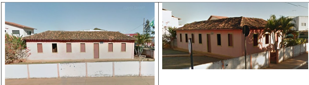
Figuras 04 e 05 – Fachadas da edificação. Fonte: Google Street View, julho 2011.
