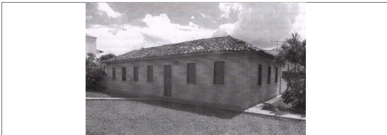
Figura 03 – Foto antiga da edificação. Fonte: Ficha de inventário do imóvel.
