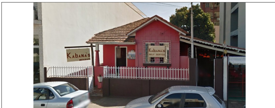
Figura 04 – Fachada da edificação antes da demolição em 2011. Fonte: Google maps.
