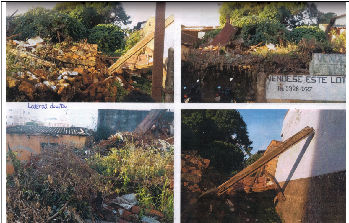
Figuras 07 a 10 – Imagens do local após o incêndio em 01/04/2016.
