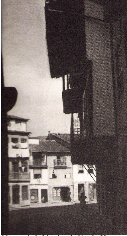
98| casario habitacional, década 50.
