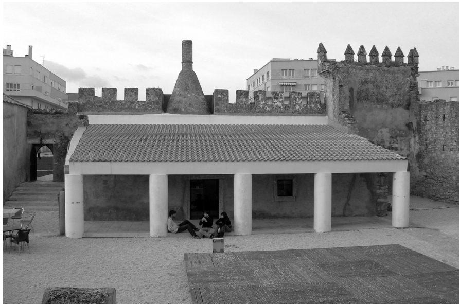
90| Reabilitação do Paço de Pirescoxe pelo IPPAR, Santa Iria de Azóia. O conjunto patrimonial está perdido no centro de uma praça e rodeado de prédios dos anos 80, perdendo qualquer relação com a envolvente.
