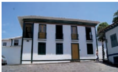
Figura 2: Casa da Chica da Silva (atual sede do escritório do IPHAN/MG), Diamantina, MG. Fagundes/2011
