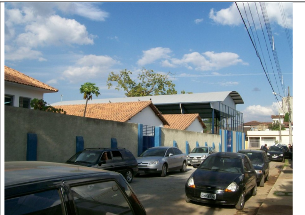
Figura 10 - Fachada lateral com os acréscimos.
