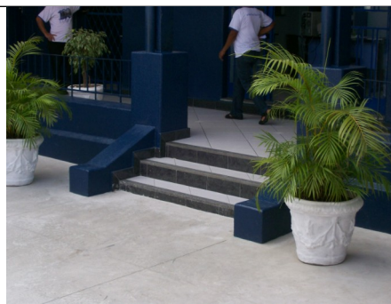
Figura 16 – Escada de acesso ao pátio central.
