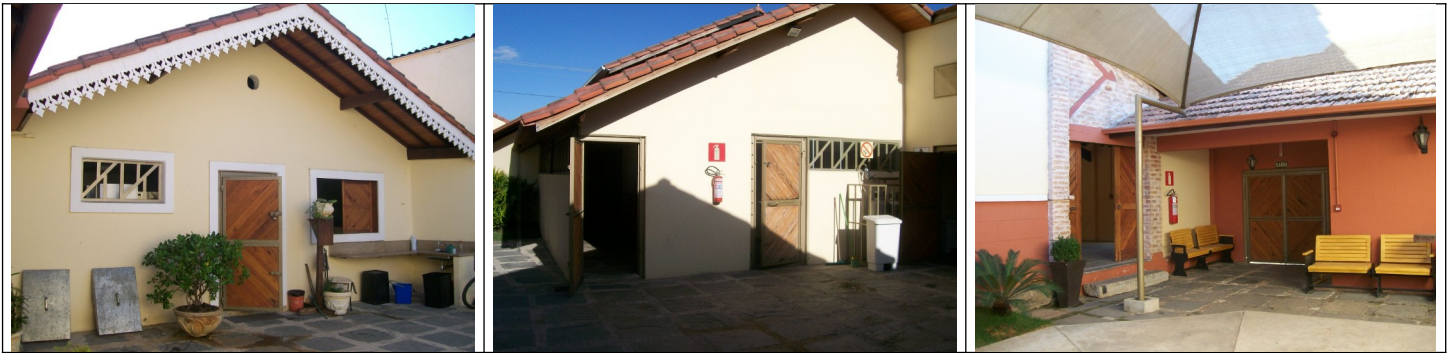
Figuras 10 a 12 – Acréscimos que se confundem com a edificação antiga.
