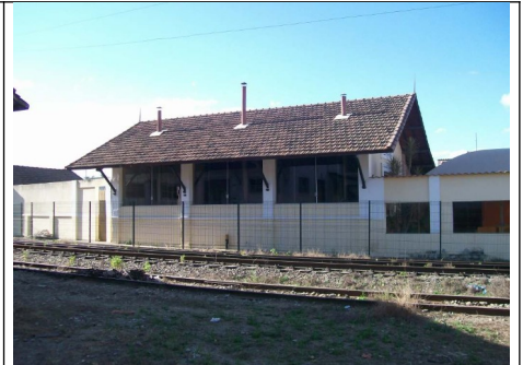
Figura 04 – Fachada lateral galpão Serraria.
