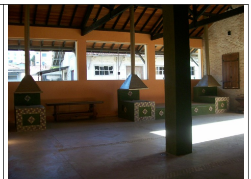
Figura 09 – Interior do galpão Serraria.
