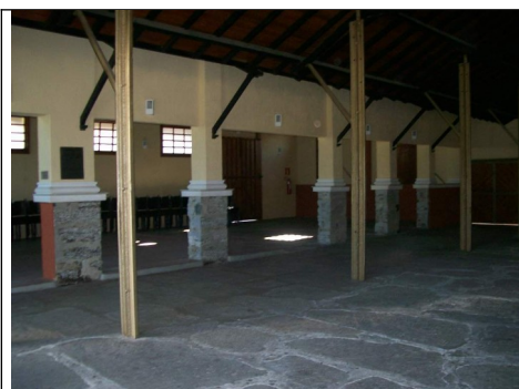
Figura 07 – Interior do galpão Almoxarifado.
