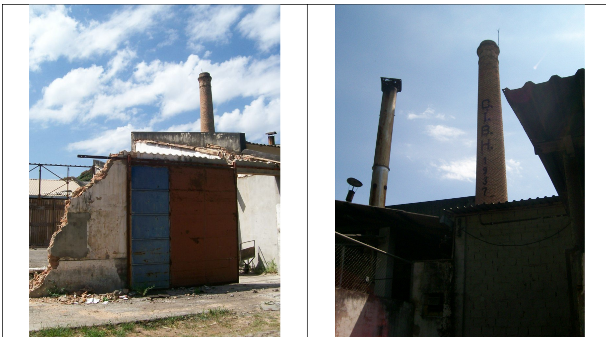
Figuras 28 e 29 – Imagem dos Galpões desmontados e a chaminé ao fundo. Figura 29, a chaminé.
