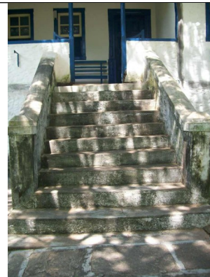
Figuras 09 e 10 – Da pequena varanda tem-se acesso ao interior por porta de verga reta. O acesso se dá por escadarias de tijolos revestida por cimento, possivelmente intervenção posterior. O guarda-corpo é do mesmo material.
