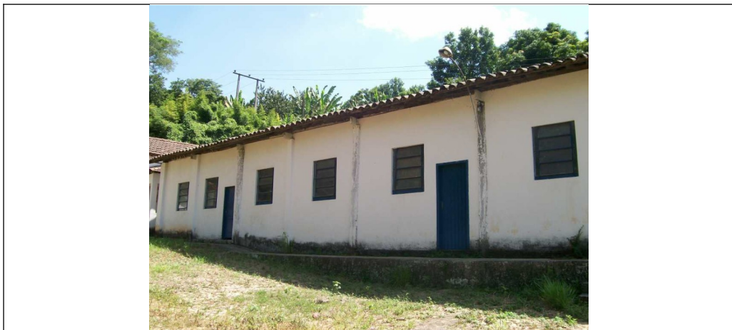
Figura 18 – A casa está disposta no sentido longitudinal, sua fachada é simples, sem detalhes. Em seu lado esquerdo, fundação que desaparece em função da declividade do terreno. Do lado direito o Centro odontológico. As janelas, todas basculantes e as portas em metal são intervenções posteriores. São três cômodos, divididos por portas e janelas, formando salas independentes. Telhado coberto por telhas coloniais.
