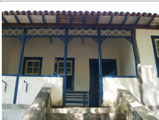
Figuras 09 e 10 – Da pequena varanda tem-se acesso ao interior por porta de verga reta. O acesso se dá por escadarias de tijolos revestida por cimento, possivelmente intervenção posterior. O guarda-corpo é do mesmo material.
