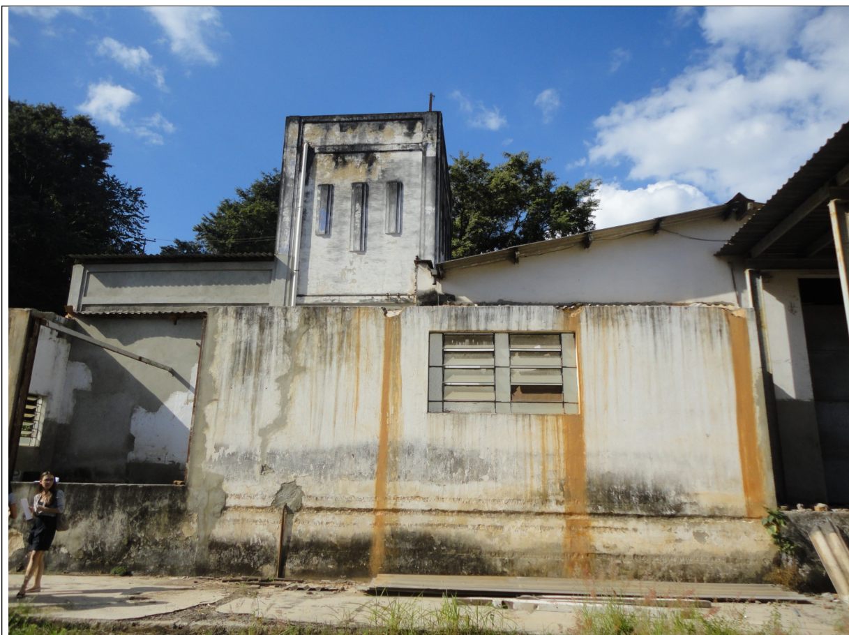
Figura 10 – Imagem da subestação de água, que deverá possuir delimitação do bem cultural, para a preservação do conjunto arquitetônico.
