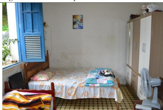
Figura 13 – Manchas de umidade na parede.
