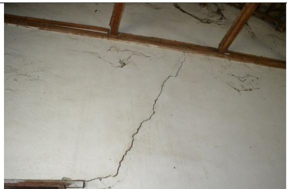
Figura 23 – Trincas nas alvenarias.
