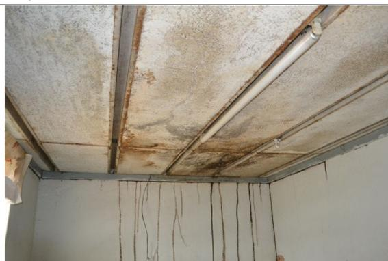
Figura 08 – Marcas que denunciam a presença de cupim de solo. Forro comprometido pela umidade e cupins.
