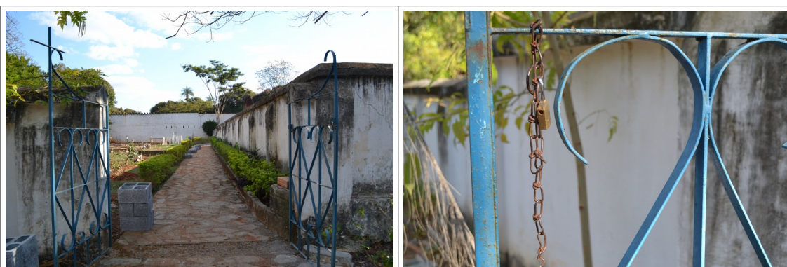
Figuras 5 e 6 - Portão de acesso ao cemitério e detalhe do cadeado e corrente utilizados para o fechamento. Fonte: CPPC.
