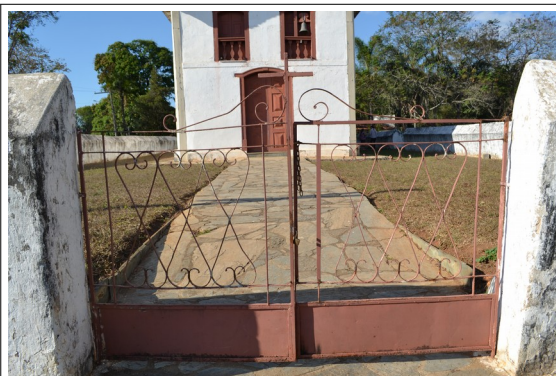
Figura 2 - Detalhe do portão de acesso. Nota-se a fragilidade da fechadura (cadeado e corrente pouco robustos), e do gradil em si. Fonte: CPPC.
