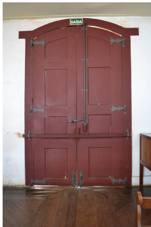
Figura 11 – Travas internas da porta frontal. Fonte: CPPC.
