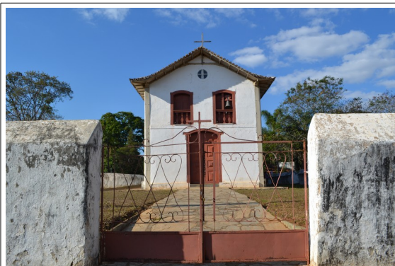
Figura 1 – Vista do portão de acesso ao adro. Fonte: CPPC.
