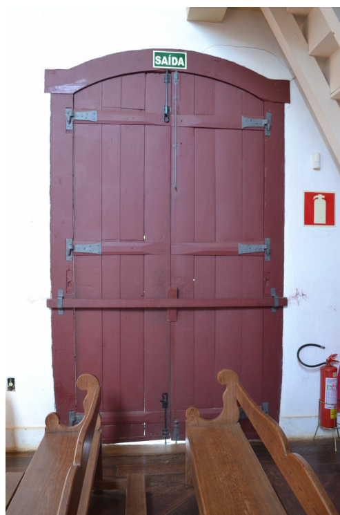
Figura 11 – Travas internas da porta frontal. Fonte: CPPC.
