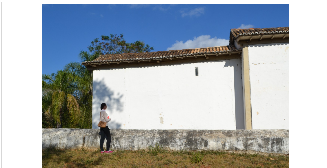
Figura 3 – Muro lateral esquerdo, onde a declividade do talude favorece o acesso ao adro. Fonte: CPPC.
