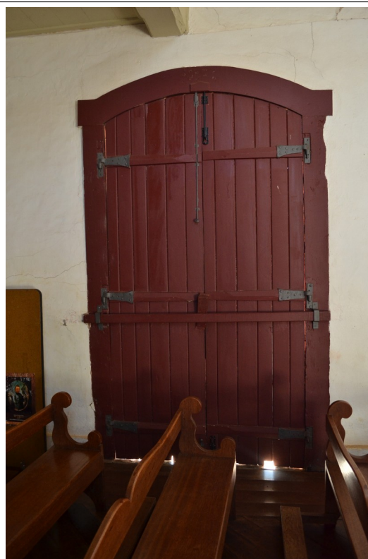
Figura 15 – Vista das travas internas da porta lateral esquerda. Fonte: CPPC.
