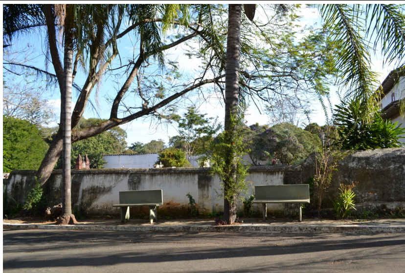
Figura 4 – Muro posterior – nota-se que a altura do muro somada a existência dos bancos no passeio favorece aqui também o acesso ao cemitério e ao adro da capela. Fonte: CPPC.
