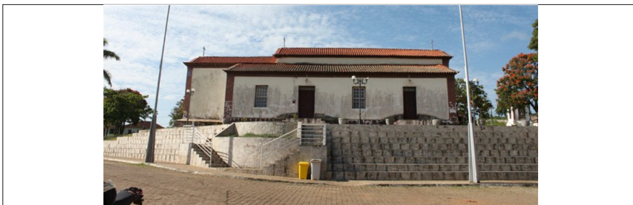
Figura 15 – Vista geral da intervenção.
