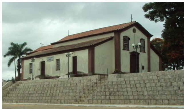
Figura 14 – Lateral esquerda posterior à intervenção.
