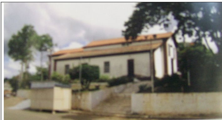
Figura 13 – Vista lateral esquerda da praça anterior à intervenção. Fonte: Dossiê de tombamento de 2006.
