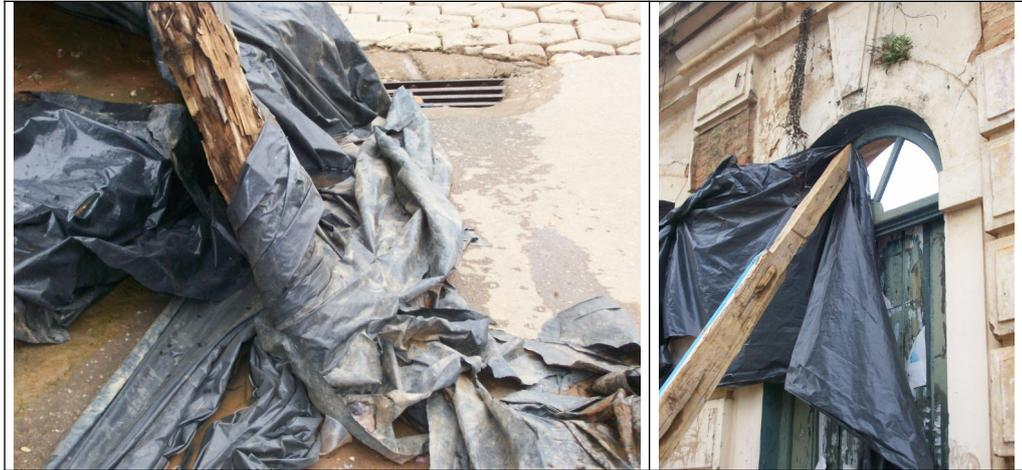
Figuras 09 e 10 – Escoramento inadequado.
