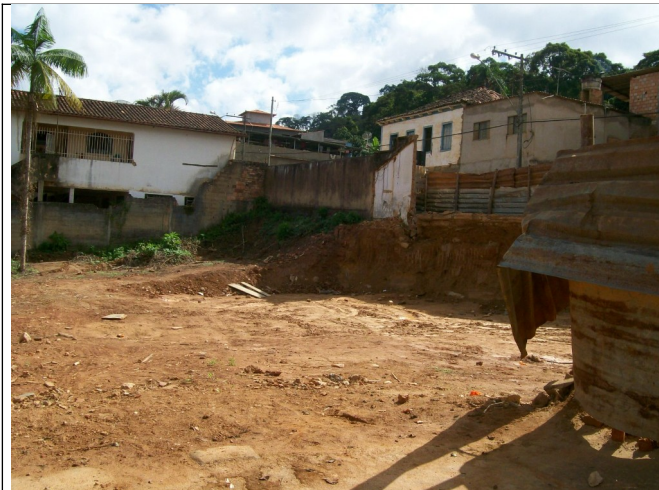
Figura 06 - Terreno limpo, após a demolição do casarão. (julho/08)
