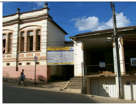
Figura 02 – Vizinhança entre o imóvel em questão e o prédio da Prefeitura, tombado pelo município. (julho/08)
