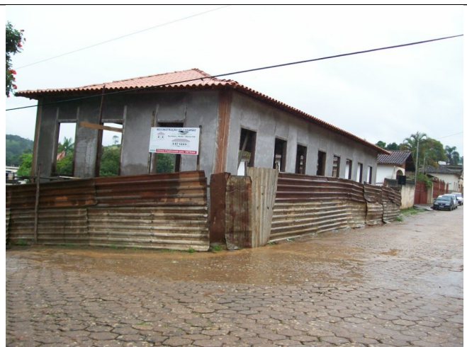
Figura 08 – Casarão em reconstrução. (fevereiro 2009)
