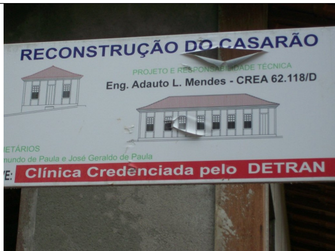
Figura 09 – Placa de obra (fevereiro/2009).
