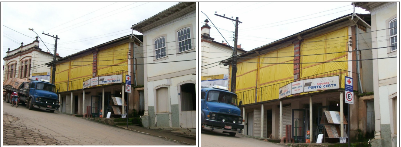
Figuras 04 e 05 – Imagens do imóvel com a fachada frontal totalmente descaracterizada.(fevereiro/2009)
