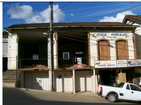
Figura 01 – Fachada principal do imóvel. (julho/08)
