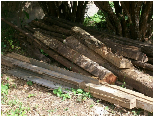
Figura 07 - Madeira remanescente que será utilizada na reconstrução. (julho/08)
