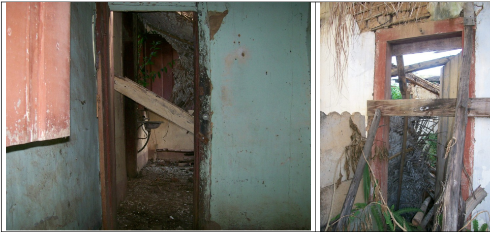
Figura 09 – Trecho da parte interna da edificação, com escoramento..
