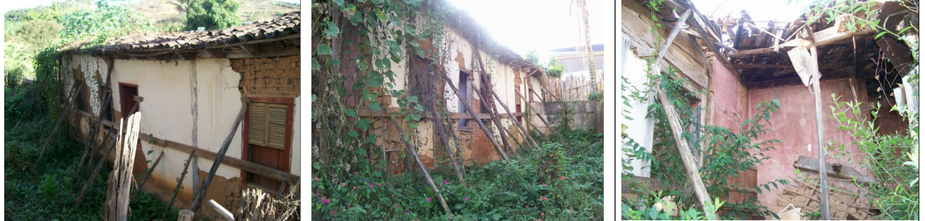
Figuras 06, 07 e 08 – Algumas paredes que permanecem de pé graças aos escoramentos existentes.
