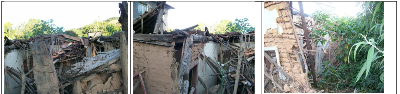
Figuras 17, 18 e 19 – Ruínas, entulhos e mato.
