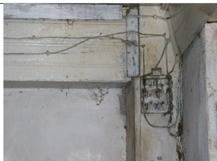
Figura 11 – Fiação exposta.
