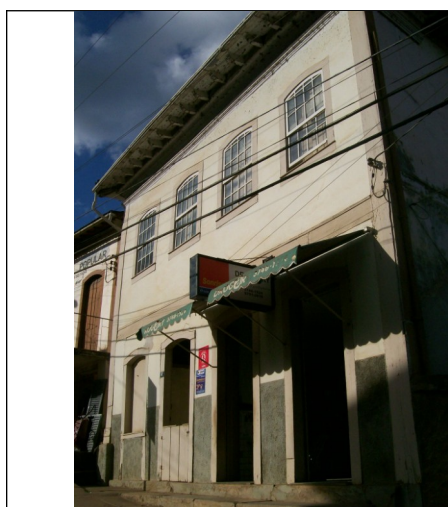
Figura 13 – Fachada frontal do imóvel.
