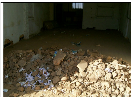
Figura 07 – Entulho referente à obra no segundo pavimento.
