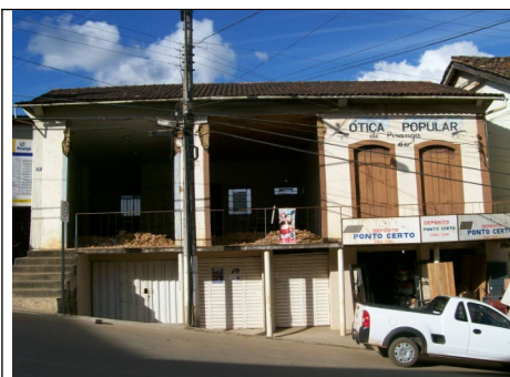
Figura 04 – Fachada principal do imóvel, onde pode-se observar as descaracterizações sofridas.
