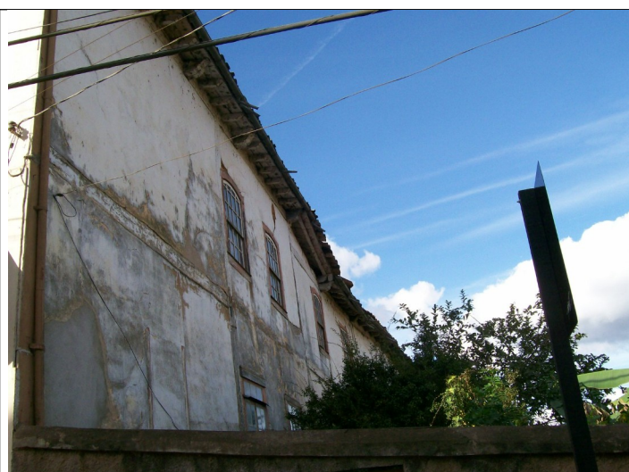
Figura 14 – Fachada lateral do imóvel.
