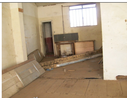
Figura 08 – Parte do material original (piso, esteios e esquadrias) no segundo pavimento da edificação.
