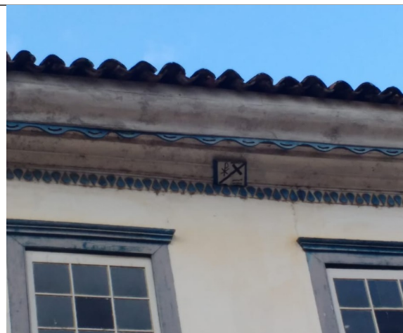
Imagem 05 – Detalhe da cimalha .
