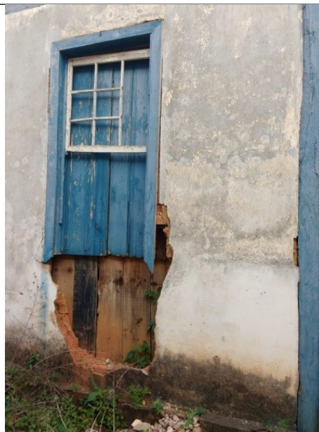
Imagem 08 – Arruinamento de trecho de alvenaria.
