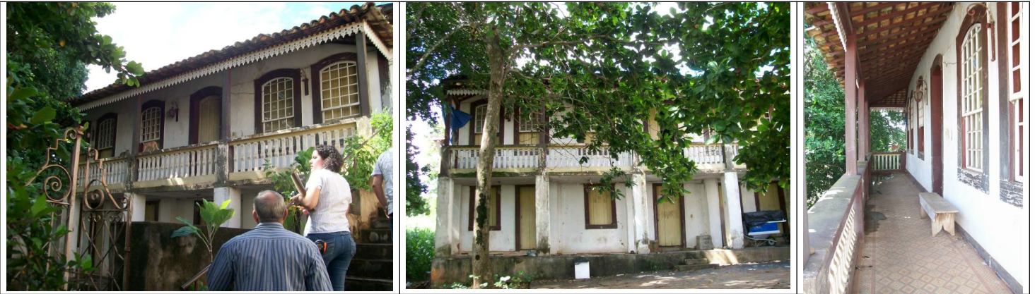
Figuras 06 a 08 – Fachada principal da edificação e detalhe da varanda
