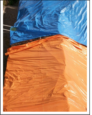
Figuras 23 e 24 – Trechos vulneráveis na junção das lonas.
