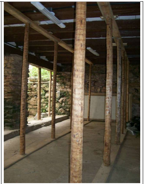
Figura 08 – Escoramento de piso cujo modelo pode ser utilizado em telhados. Fonte: acervo pessoal
