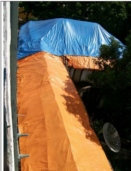
Figura 25 – Lonamento sobre cobertura.
