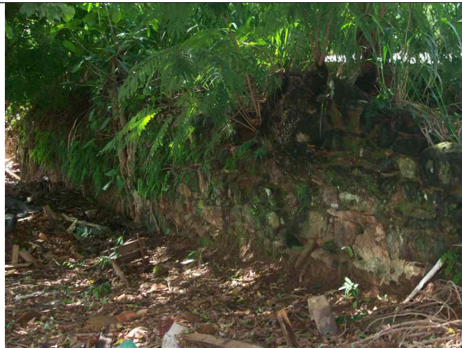
Figura 09 – Muro de pedras junto à fachada principal.
