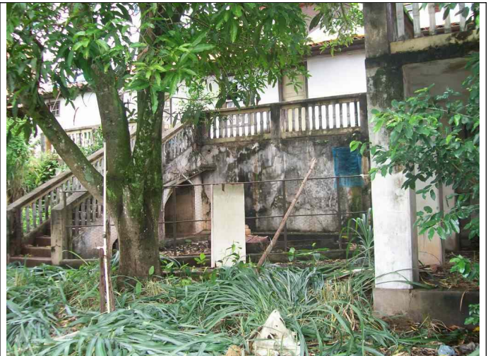
Figura 10 – Trecho da fachada lateral direita.
