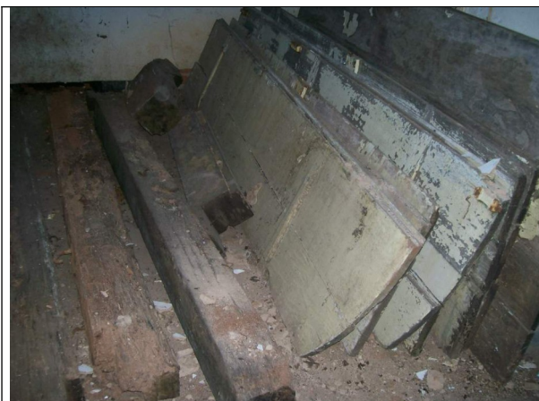
Figura 27 – Esquadrias armazenadas no interior da edificação.
