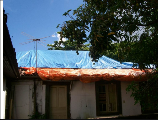
Figuras 23 e 24 – Trechos vulneráveis na junção das lonas.
