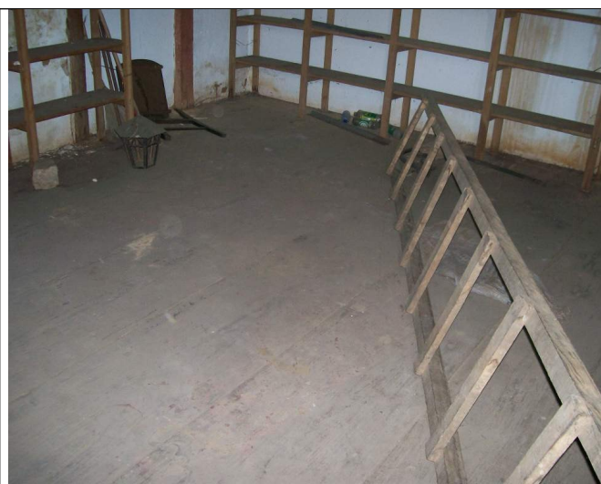
Figura 19 – Piso tabuado de madeira.
