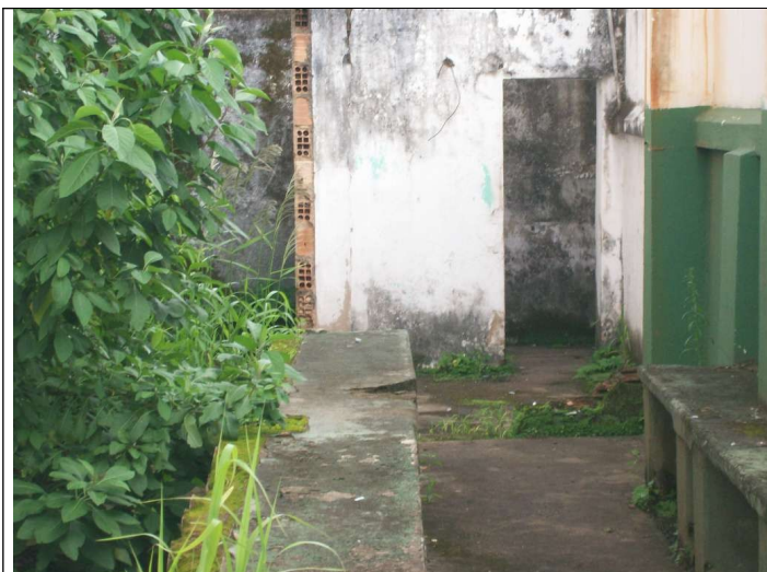
Figura 28 – Vegetação junto à base da edificação.
