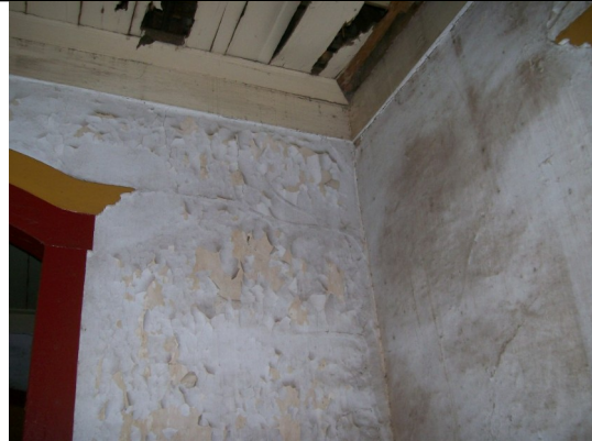
Figuras 20 e 21 – Patologias nas alvenarias.
