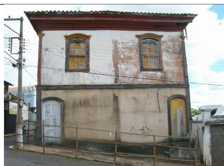
Figura 06 - Fachada lateral direita
