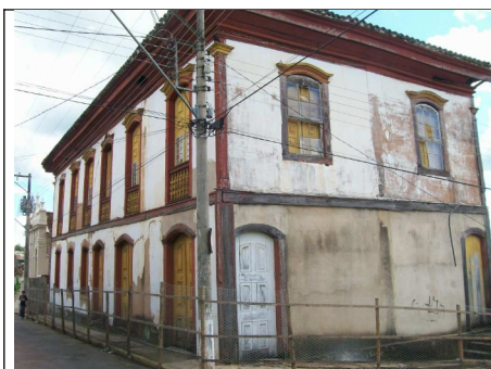
Figura 05 – Fachadas da edificação.
