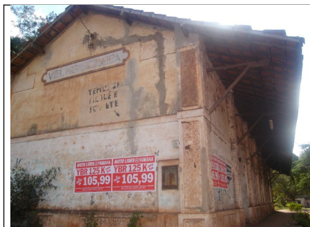
Figura 06 - Fachada lateral esquerda
