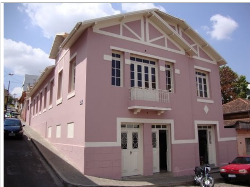
Figura 01 – Fachada do Clube Velho após as obras.
