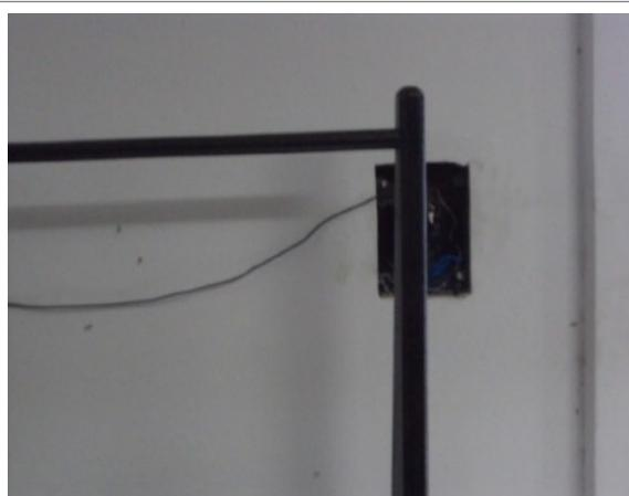
Figura 25 – Fiação correndo fora de eletroduto.
