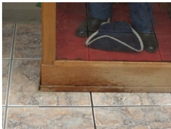
Figura 47 – Detalhe da marca de água causada pela goteira.
