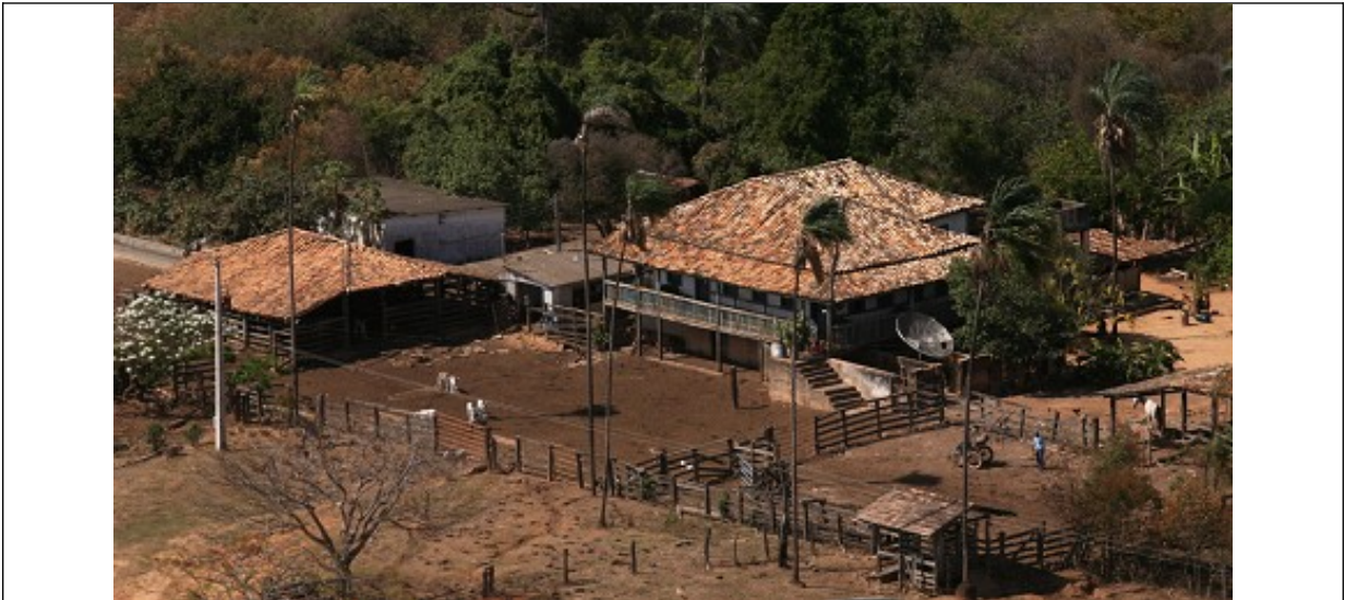
Figura 03 – Vista aérea do conjunto arquitetônico da Fazenda do Laranjo. Fonte: Laudo Técnico nº 024/2008, elaborado pelo Setor Técnico desta Promotoria.
