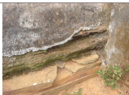
Figura 19 – Madeira estrutural desgastada pela umidade e manchas de bolor no reboco.
