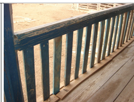
Figura 08 – Guarda corpo da varanda.
