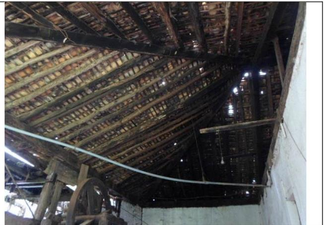
Figura 05 – Detalhe da cobertura do moinho, com comprometimento das madeiras e ausência de telhas. Imagens: Promotoria de Justiça de Pompéu.
