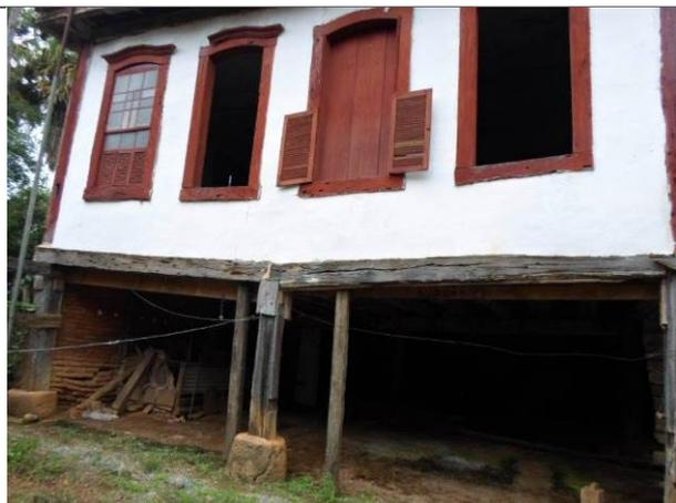
Figura 09 – Vista da estrutura em madeira, com sinais de apodrecimento, umidade, perda de material e presença de insetos xilófagos. Imagens: Promotoria de Justiça de Pompéu.
