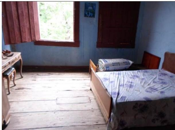
Figura 07 – Detalhe do ressecamento da madeira, bem como da perda pontual de matéria no piso em madeira. Imagens: Promotoria de Justiça de Pompéu.
