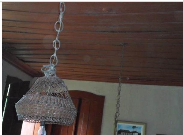
Figura 08 – Detalhe do forro em madeira, do tipo saia-camisinha, com várias peças empenadas. Imagens: Promotoria de Justiça de Pompéu.
