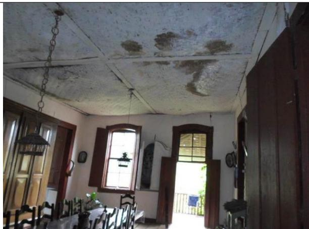
Figura 06 – Detalhe da presença de manchas de umidade no forro de esteira. Imagens: Promotoria de Justiça de Pompéu.
