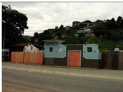
Figura 09 – Estação de Palmeiras em processo de demolição em dezembro de 2010.
