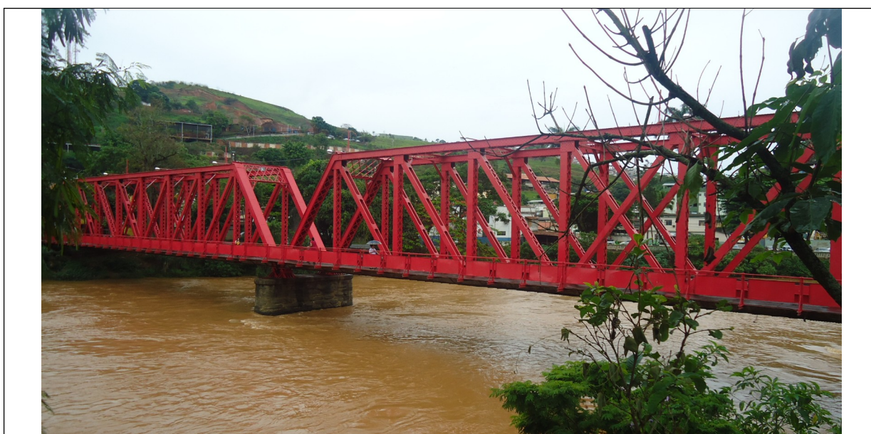
Figura 10 – Pontilhão de Ferro
