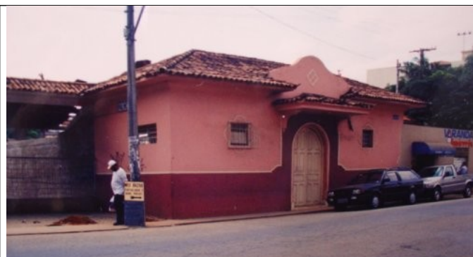
Figura 08 – Estação de Palmeiras antes da demolição em 2007.
