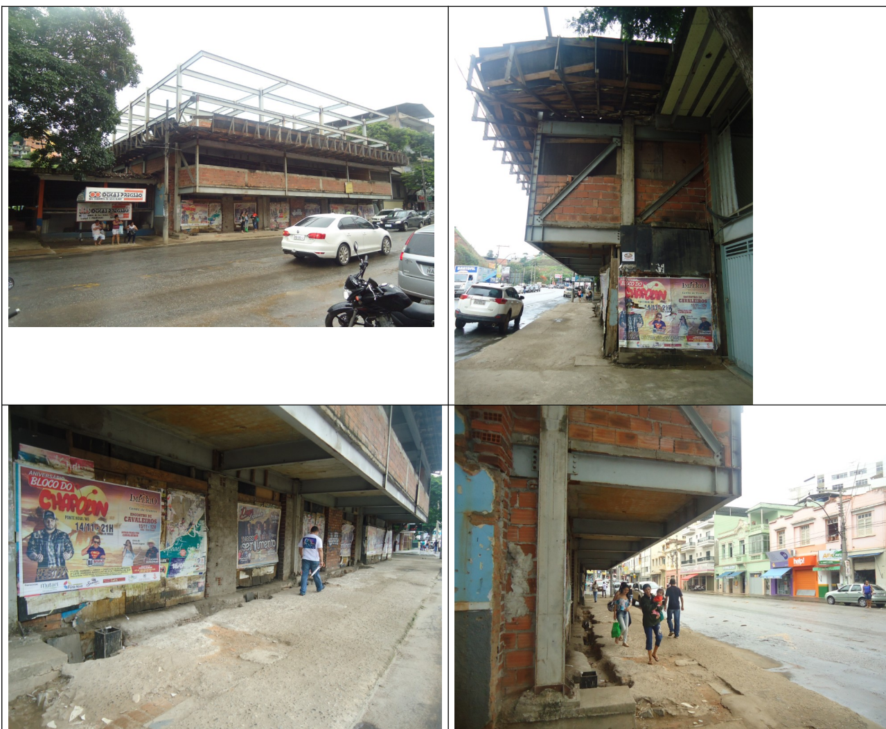
Figuras 11 a 14 – Imagens da obra paralisada e das péssimas condições da calçada.
