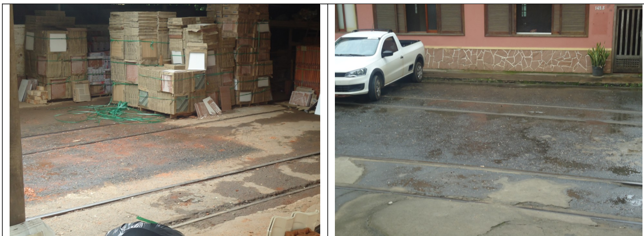
Figuras 15 e 16 – Trilhos ainda existentes no interior dos imóveis da vizinhança.
