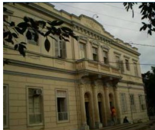
Figura 26- Imagem atual do Hospital Nossa Senhora das Dores. Fonte: Documentação fotográfica acostada aos autos.
