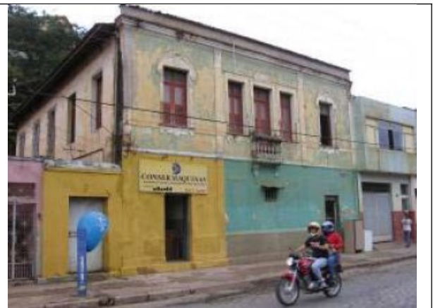
Figura 11 – Imagem de edificação de uso misto na Av. Dr. Arthur Bernardes. Fonte: Dossiê de Tombamento do Núcleo Histórico de Ponte Nova.
