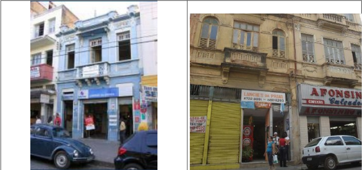
Figuras 19 e 20- Imagens mostrando a poluição visual no centro histórico de Ponte Nova, imóveis situados à Av. Dr. Caetano Matinho e Rua Benedito Valadares, respectivamente. Fonte: Dossiê de Tombamento do Núcleo Histórico de Ponte Nova.
