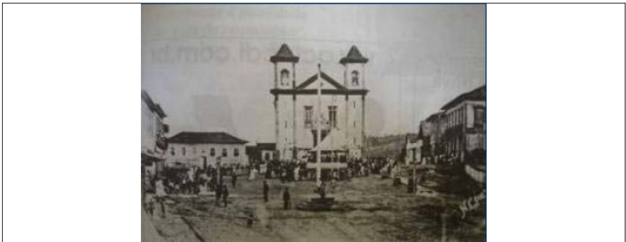
Figura 03 – Antiga Igreja Matriz de Ponte Nova, construída pelo padre José Miguel Martins Chaves. Fonte: Dossiê de Tombamento do Núcleo Histórico de Ponte Nova
