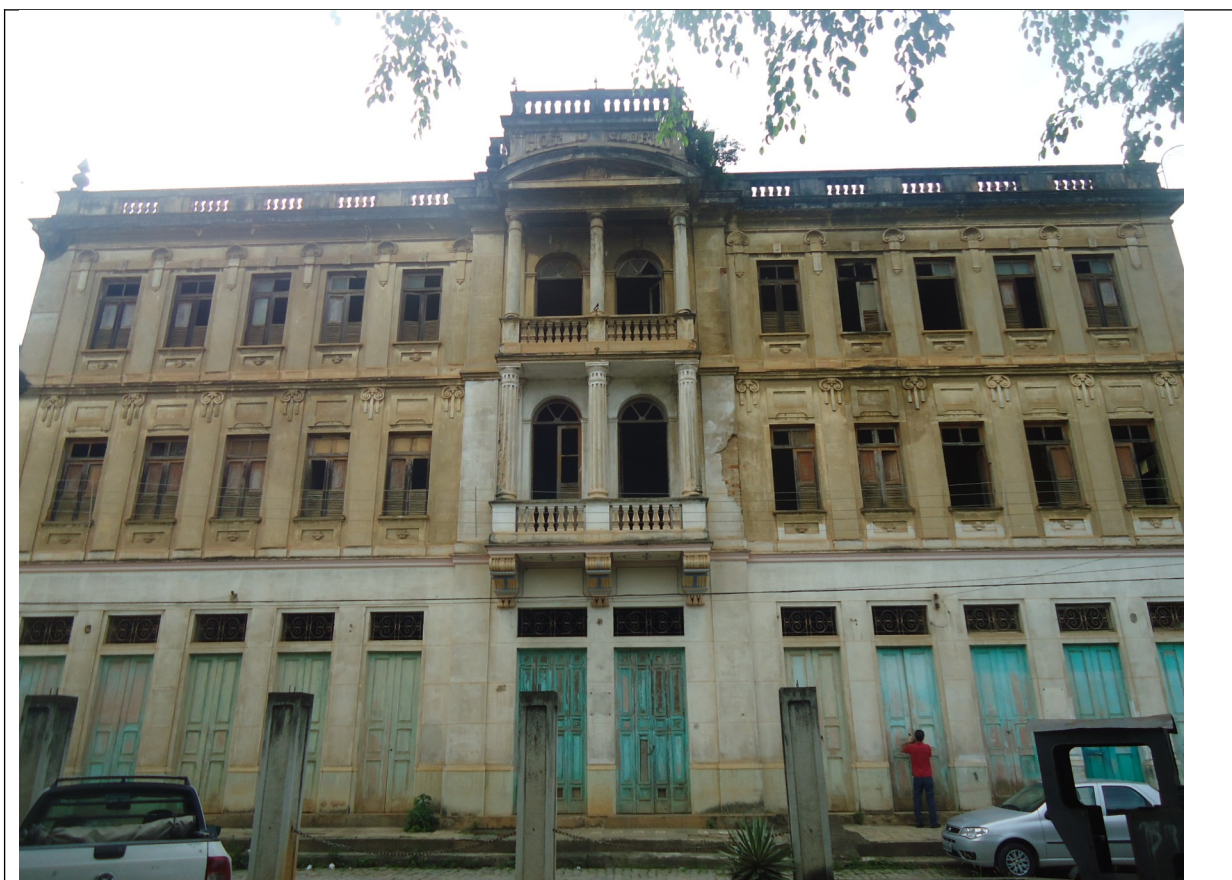
Figura 08 – Fachada frontal do Hotel Glória.
