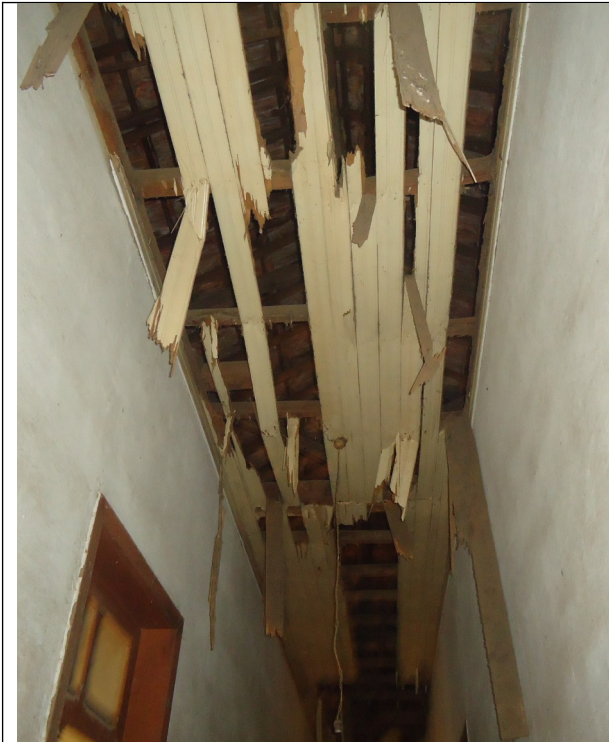
Figura 27 – Forros danificados.
